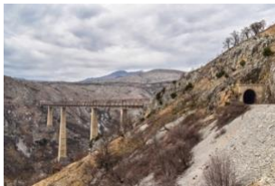
Europas höchste Eisenbahnbrücke: Das 198 Meter hohe Mala-Rijeka-Viadukt in Montenegro
